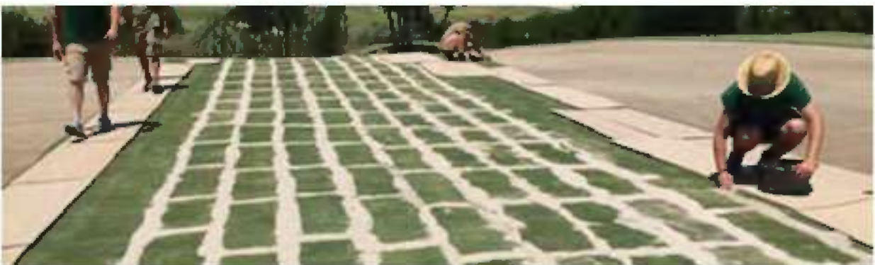
Colocación de los tepes de Bermuda enana.
